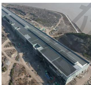
光伏屋面一体化
